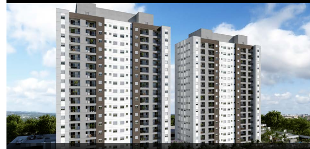
KAIROS Condomínio vertical | Santa Bárbara d'Oeste
